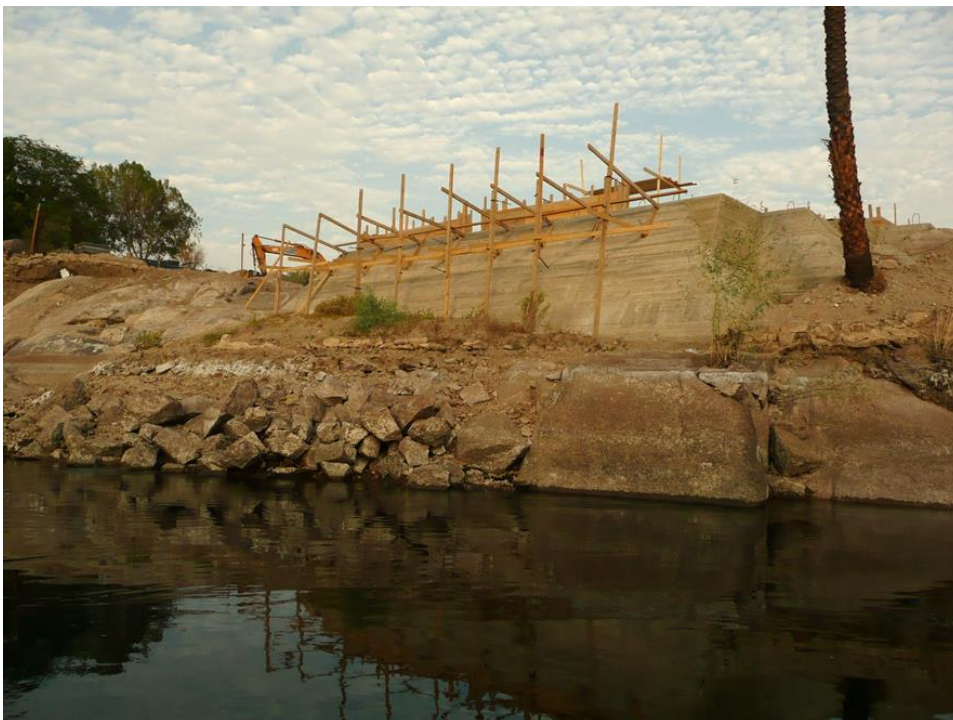
Construcción en el borde del cauce fluvial.
